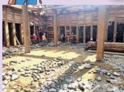
▲ 擋土襯版施工
