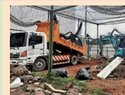
棒球隊修整建工程地下樹根刨除與鋼柱地基開挖
