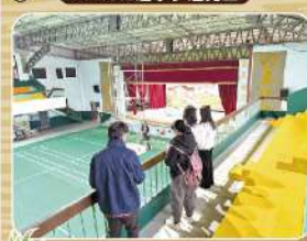
114.3.14中山樓緊急拆除工程
