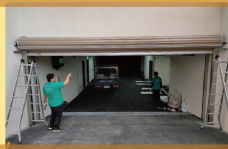
1130206 A 棟快速捲門及車牌辨識系統安裝
