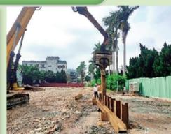
▲ 擋土排樁鑽掘打設
